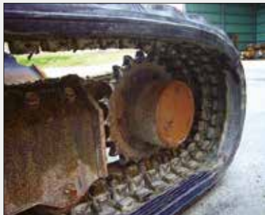
Detracking am Kettenrad
