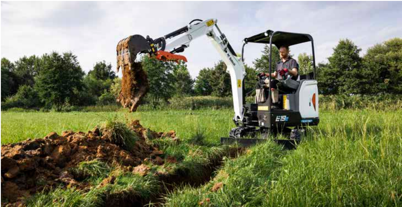
Grabenaushub mit dem E19e
